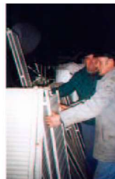
besonders die Teile für die neue Heizung werden dringend benötigt
